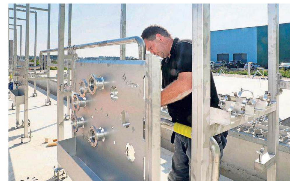
FOTO MARC MOUSSAULT Montage gebeurt ter plekke, zoals hier bij de plek waar de melktanks komen.
